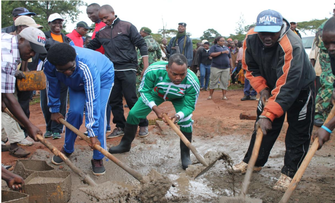
Travaux de construction d'un stade moderne à Karusi
